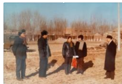
图 2 李浦新书记（左一）与大楼建设工程人员实地勘察
